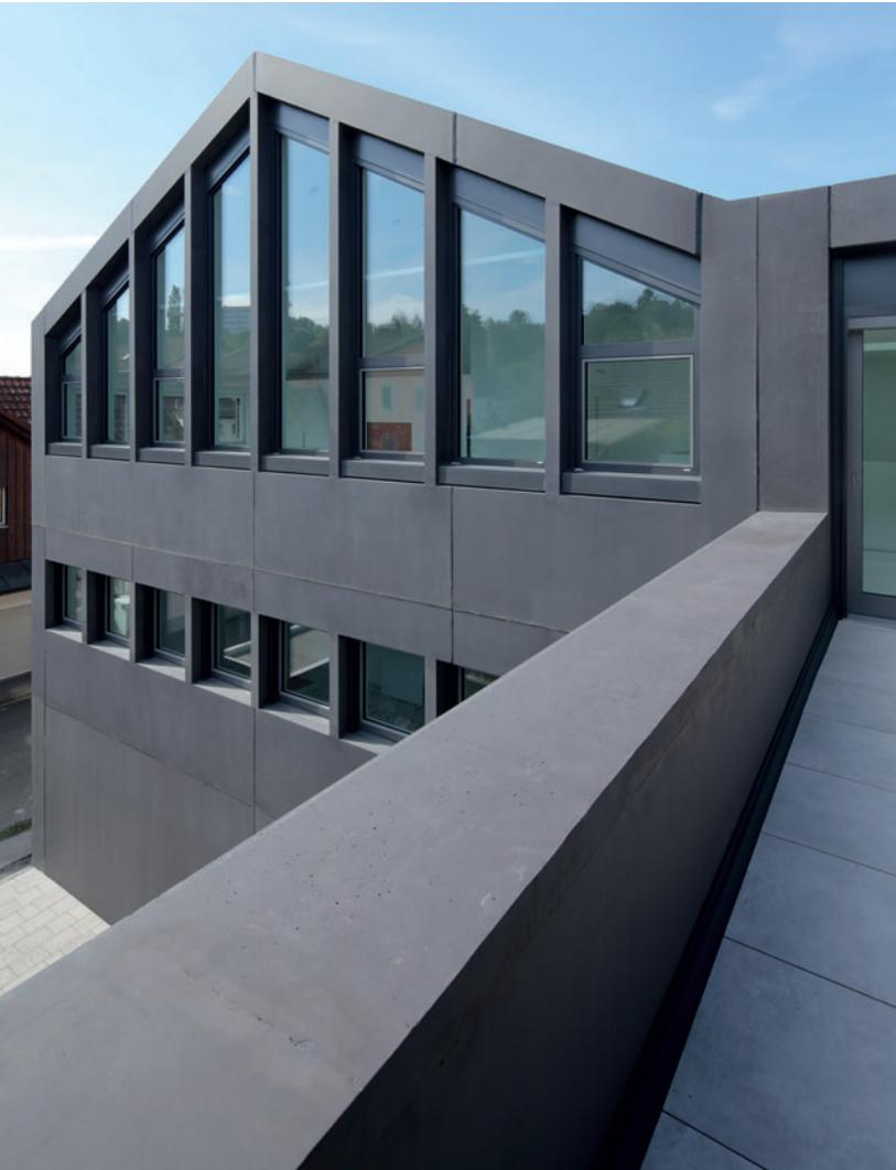
Das Gebäude bildet durch seinen rückspringenden Baukörper einen privaten Innenhof und steht an drei von vier Seiten Rücken an Rücken mit der Nachbarbebauung. Das lässt eine Belichtung nur hofseitig und von oben zu. Die Verglasung wird durch tragende Stützen gegliedert. Diese sind thermisch getrennt, gerade einmal 14 cm breit und besonders im Bereich des Giebelraums ein markantes Gestaltungsmittel.
