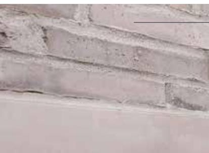
Beispiel: Mikrobiologie der LMU, Oberschleißheim. Der Glasfaserbeton unten wurde an die Klinkerwand oben angepasst.
