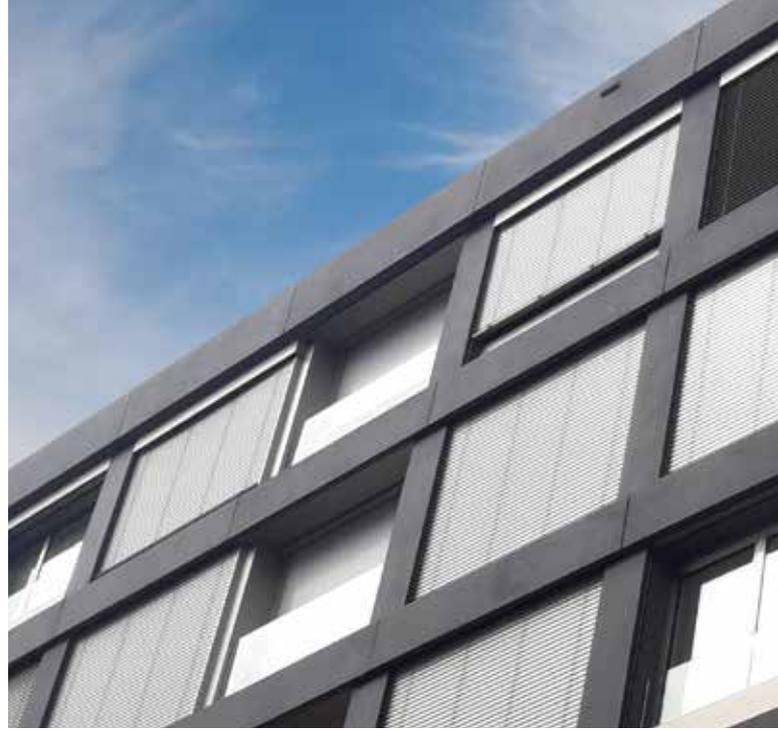
**CR fibre – das sind mit Glasfaser verstärkte Beton-Elemente, die die Vorteile beider Materialien vereinen. Für Fassaden mit individuellem Charakter.**
